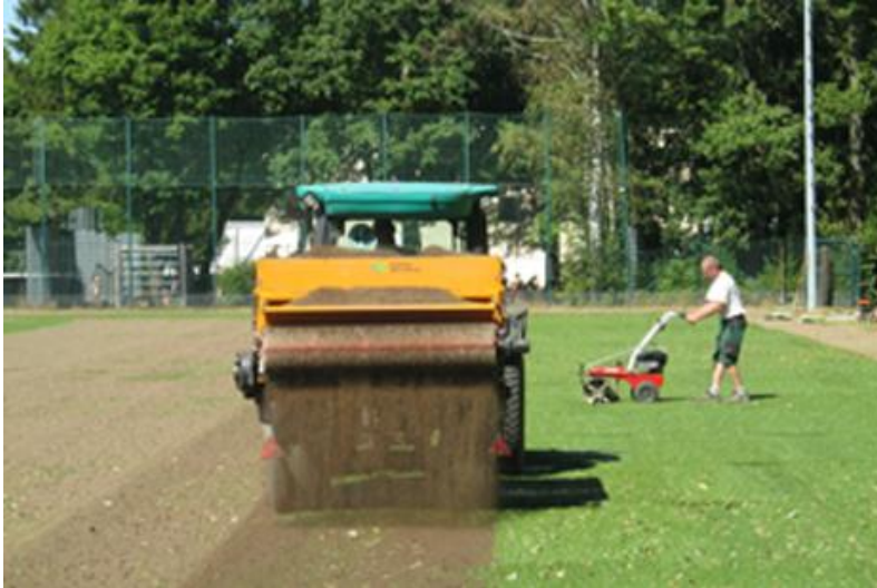
Verfüllen der Matte mit Rasentragschicht Material (RTS) Bild: EUROGREEN GmbH
