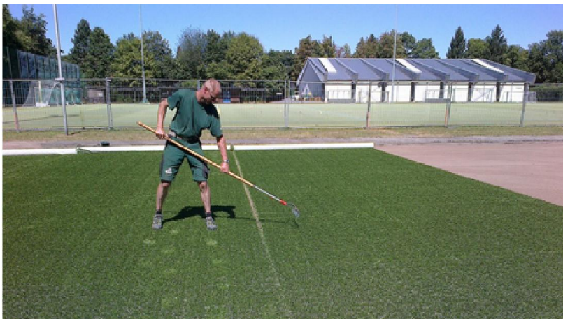
Verlegen der Matte auf vorbereitetem Planum Bild: EUROGREEN GmbH
